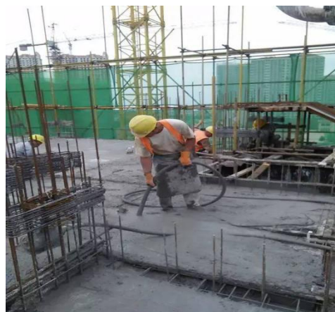
混凝土高频内置振动棒施工
