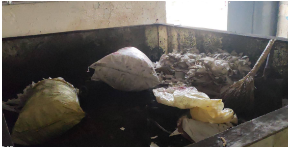
危险废物混入建筑垃圾
