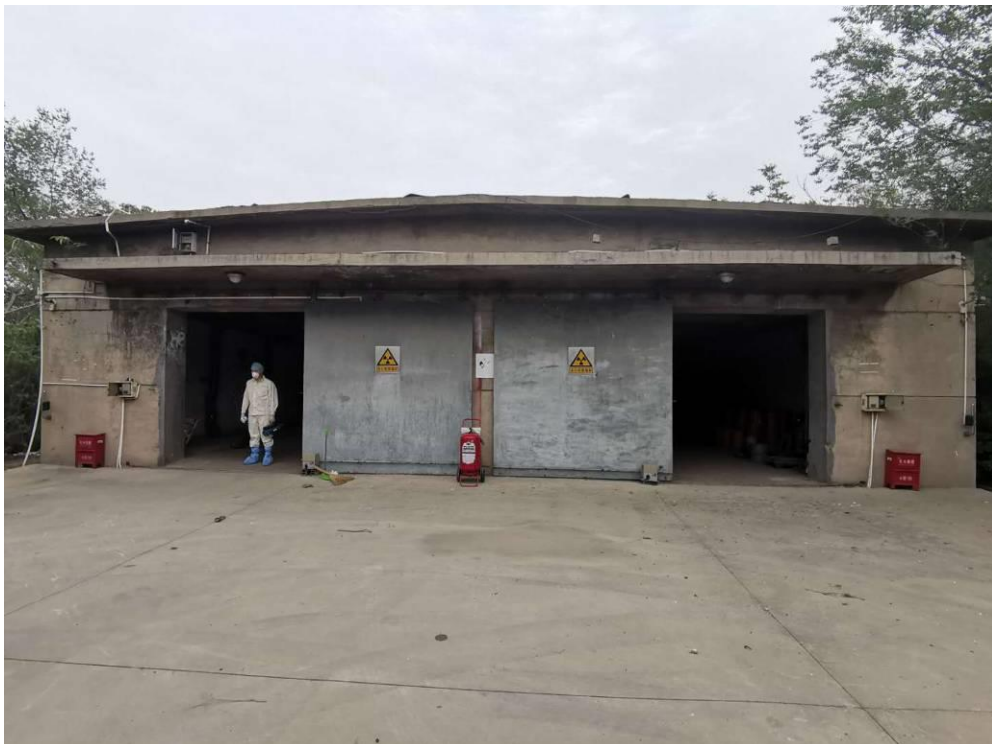
图 1-2 放废库库房外观图
